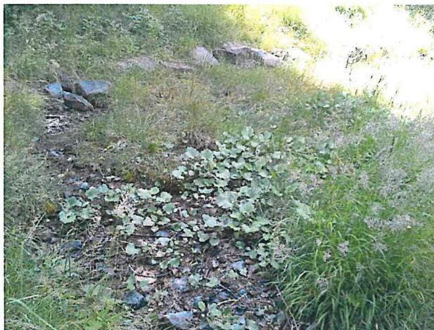
Captage par drain souterrain
