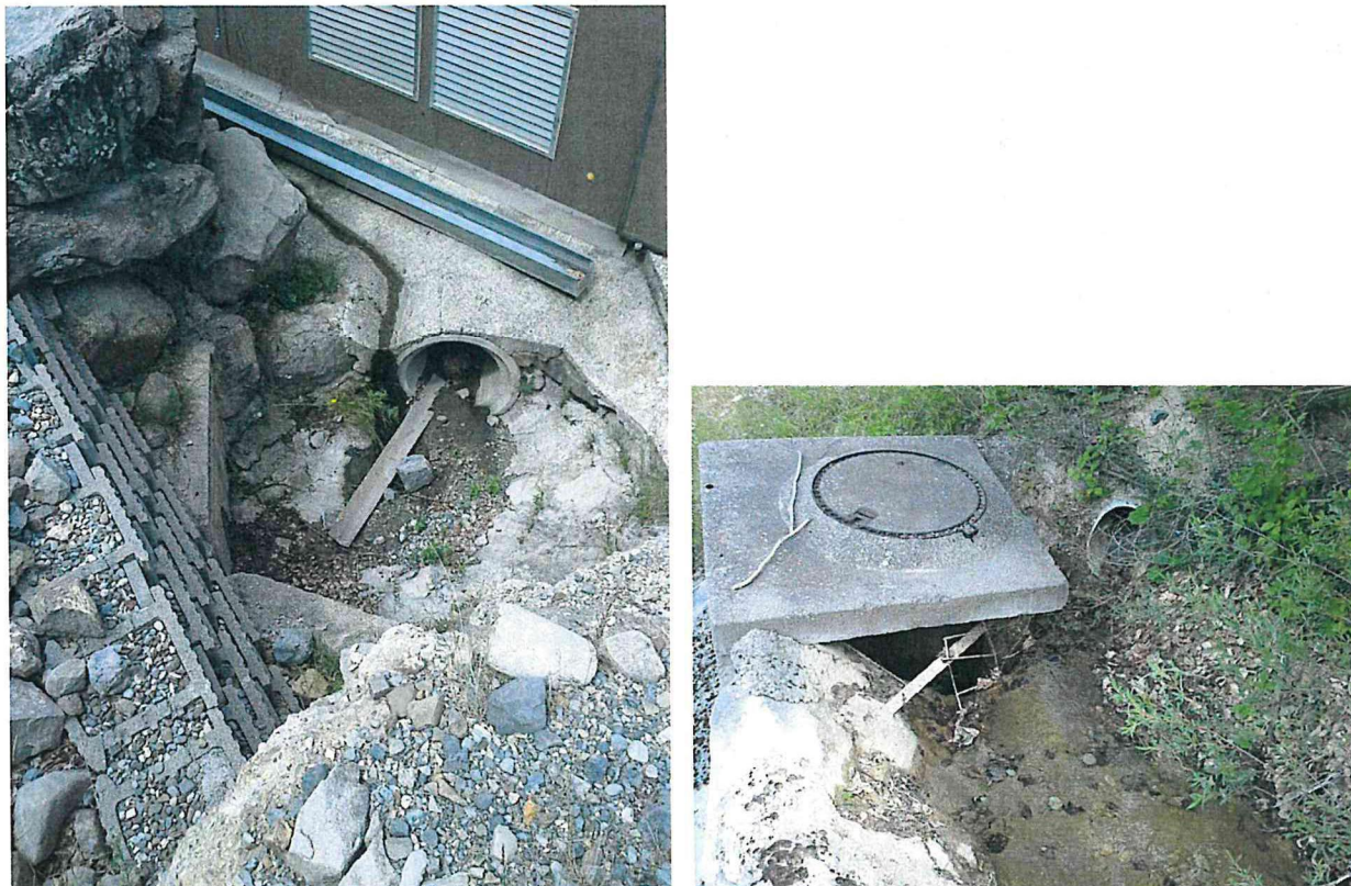
Ouvrages canalisant le ravin de la CAF
