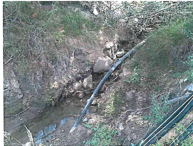
Tuyaux de prélèvement dans le ravin de Galisson
