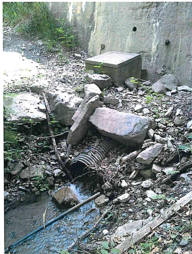
Écoulement des eaux du ravin de Galisson dans une buse en pied d'ouvrage
