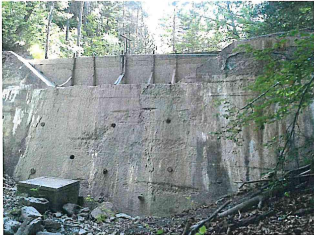
Face aval du barrage et regard de prélèvement
