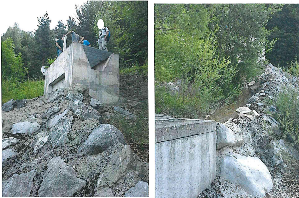
Ouvrages canalisant le ravin de la CAF
