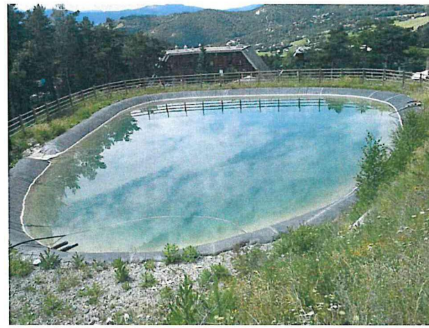
Retenue des Maisonnettes : vue d'ensemble
