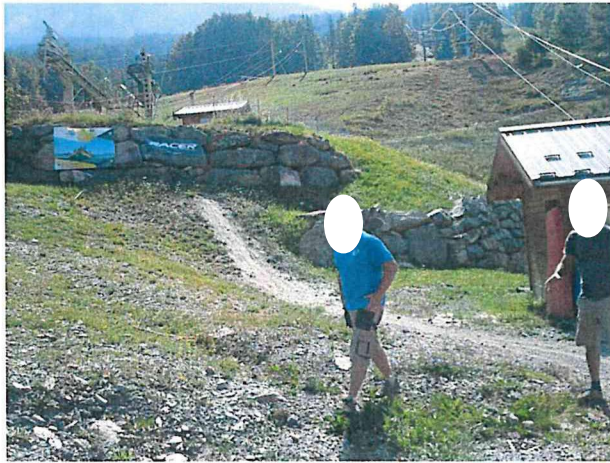
Regard entre les deux enrochements
