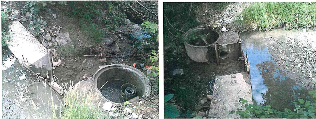
Barrage et captage
