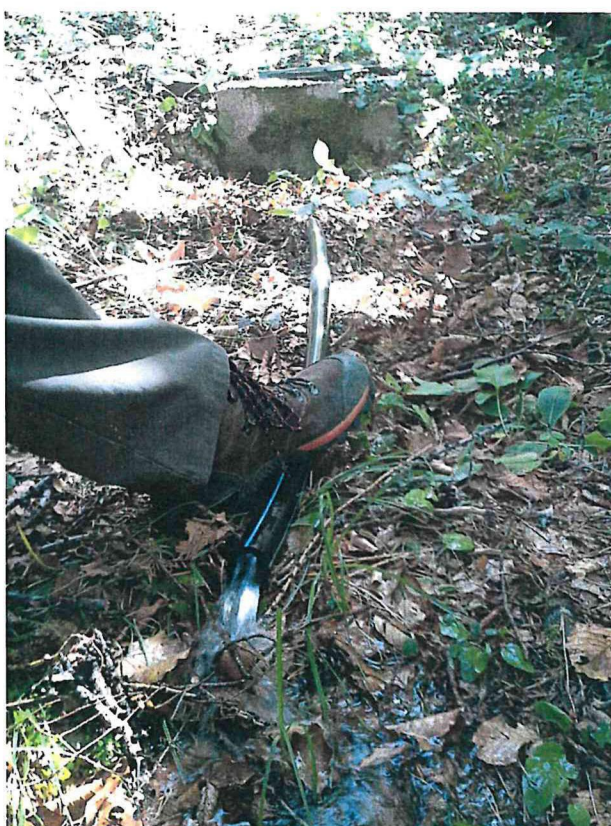
Tuyau de prélèvement hors service
