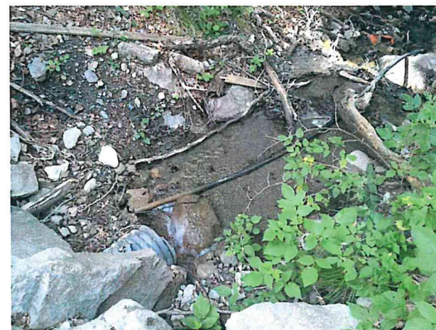
Écoulement des eaux du ravin de Galisson dans une buse en pied d'ouvrage
