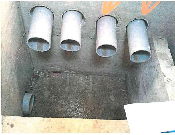
Arrivée des drains de la cuvette
